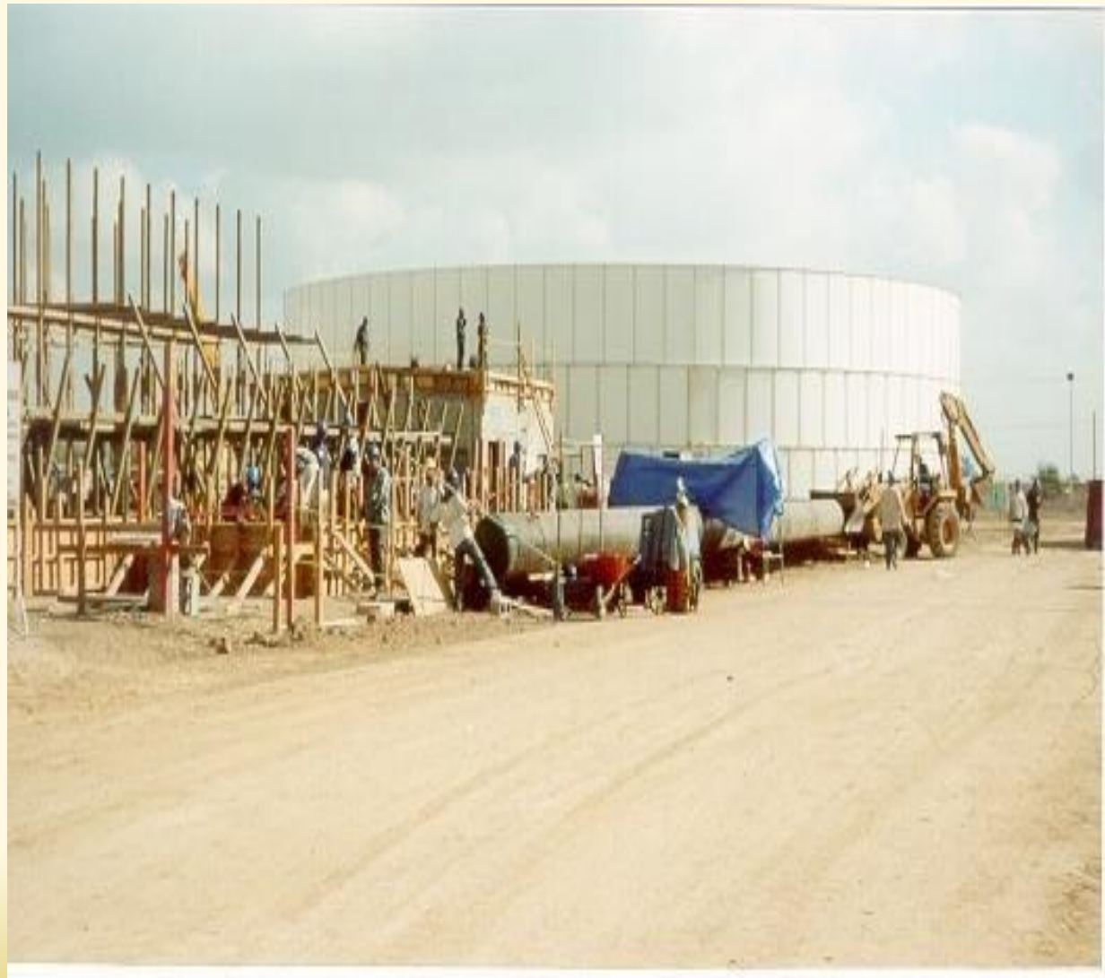
PLANTA THOMSON, MEXICALI
